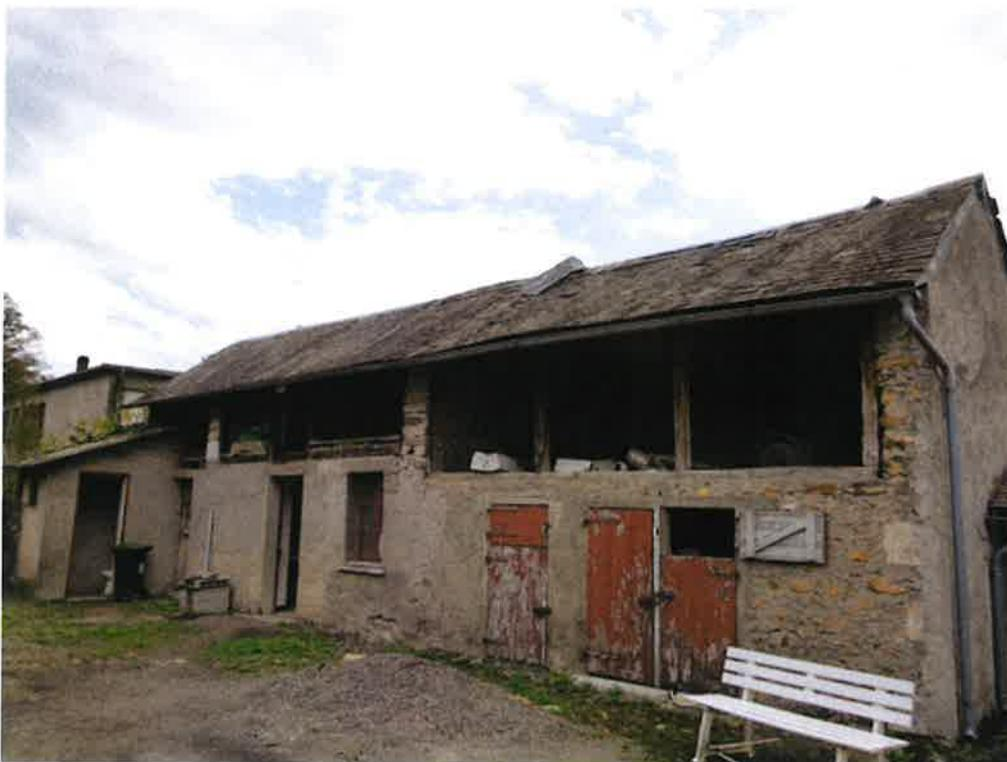
La toiture est en mauvais état, dépend de zinc arrachés, la couverture marque des ondulations, de nombreuses ardoises sont cassées, désaxées ou manquantes.
