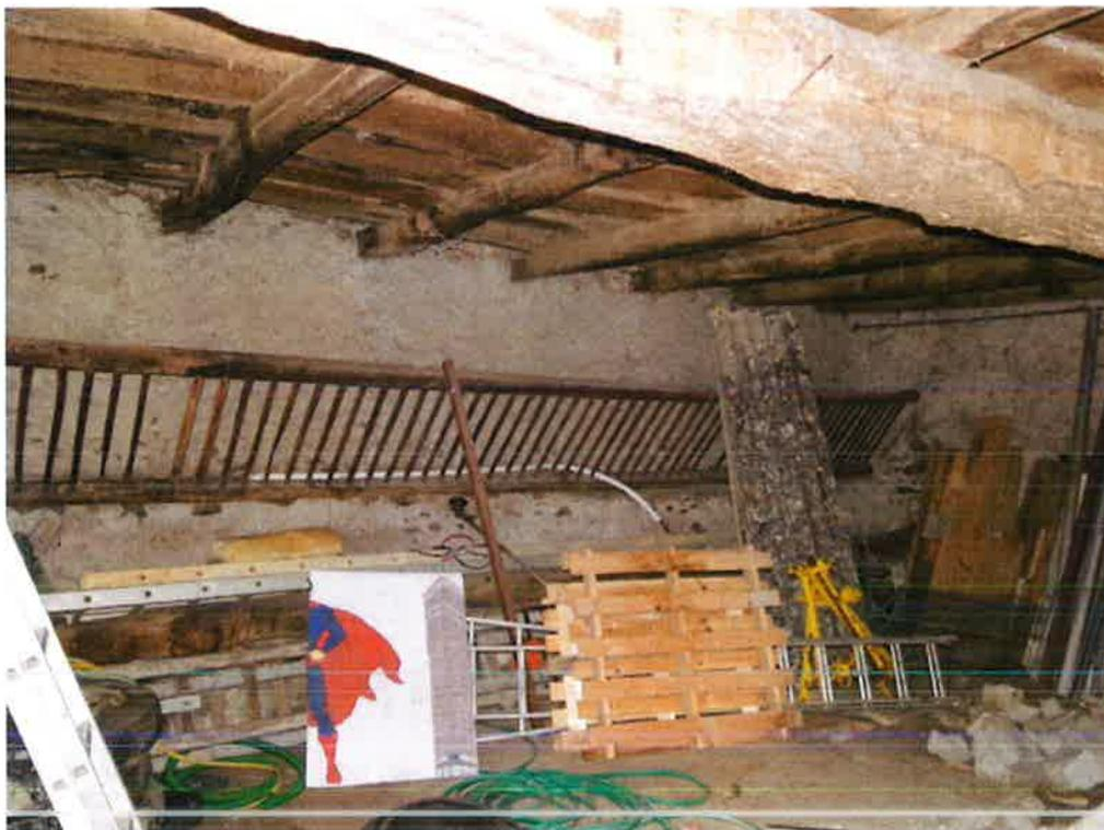
Les murs de l'étable sont anciens, bruts, au plafond une poutraison ancienne soutient un plancher en très mauvais état comparable à celui du préau voisin.
